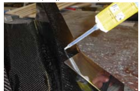
Verkleben von Edelstahl und Karbon im Yachtbau
